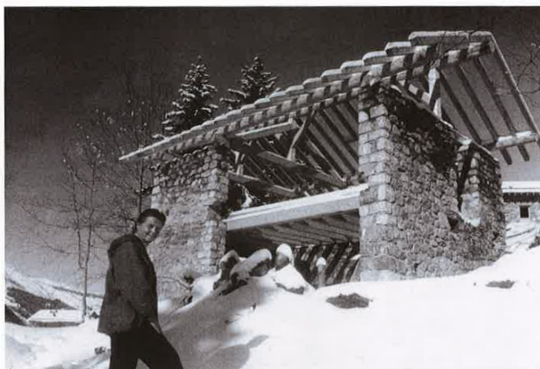
Charlotte Perriand devant le chalet en construction, 1960.
