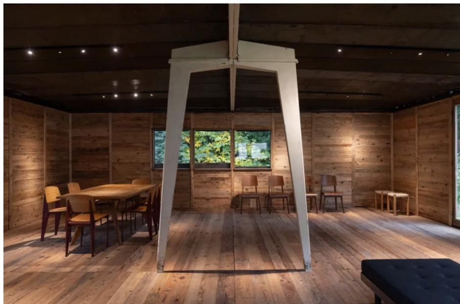
活跃于法国反抗组织的设计师 Jean Prouvé (1901-1984) , 在1944年法国解放后被选为Nancy的市长，并开始着手为无家可归的人建构出专门用于第二次世界大战后安置平民的装配式住宅。这些住宅的早期平面为 6x6m, 后来改成 8x8m, 全部用经济的木材和钢铁，完全适应二战后的原材料匮乏，还可以轻松组装拆卸，结构中空。整个体量仅以房屋中央的钢柱与四周框架支撑。
