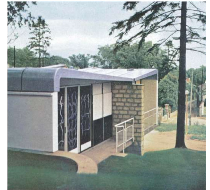
CHANTIER D'EXPÉRIENCES A MEUDON ANDRÉ SIVÉ ET HENRI PROUVÉ, ARCHITECTES JEAN PROUVÉ, CONSTRUCTEUR
